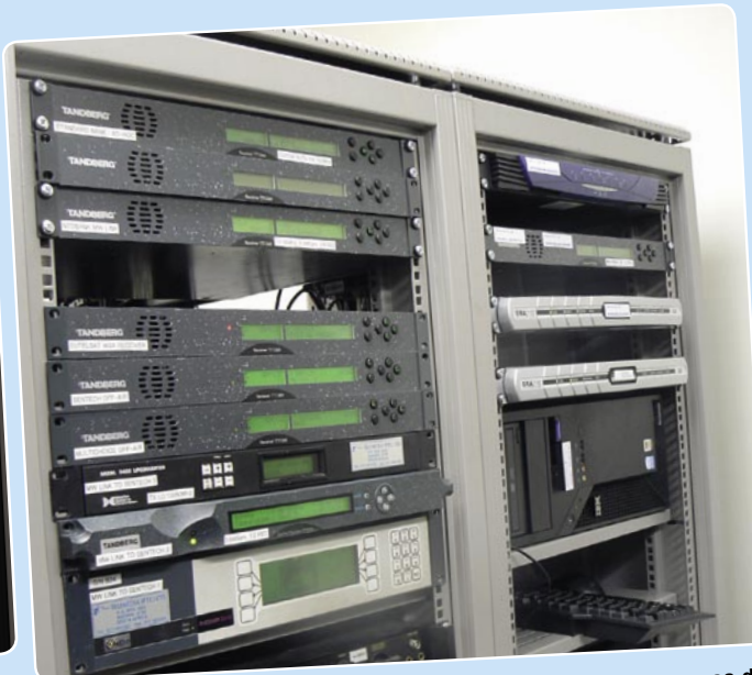
Tu przetwarzane są sygnały. Urządzenia Tandberga przeznaczone są do pracy satelitarnej. Ponadto jest tu też link z sygnałem naziemnym dla SENTECH-a, południowoafrykańskiego dystrybutora sygnału.
