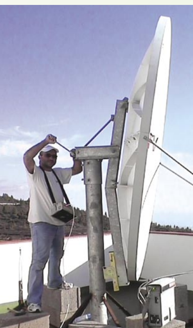
■ W oczy rzuca się niska elewacja właściwa dla odbioru amerykańskich satelitów. Ponieważ Diego mieszka wysoko w górach, daje radę utrzymać odbiór nawet przy tak małych elewacjach.
