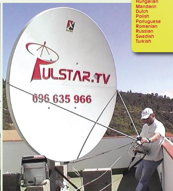
■ W oczy rzuca się niska elewacja właściwa dla odbioru amerykańskich satelitów. Ponieważ Diego mieszka wysoko w górach, daje radę utrzymać odbiór nawet przy tak małych elewacjach.
