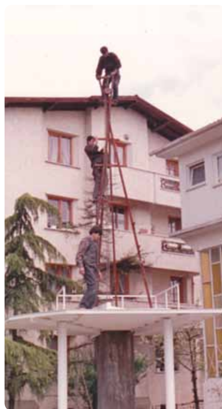
■ Przygotowanie ramy montażowej.
