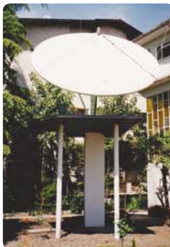
■ Skończone! Antena zamontowana.
