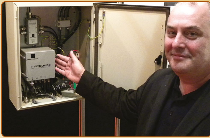
■ Nowa obudowa GlobalInvacom ze zwielokrotnionymi elementami ODU32 ma osiem identycznych wyjść optycznych, mogących zasilić do 256 punktów odbioru.
